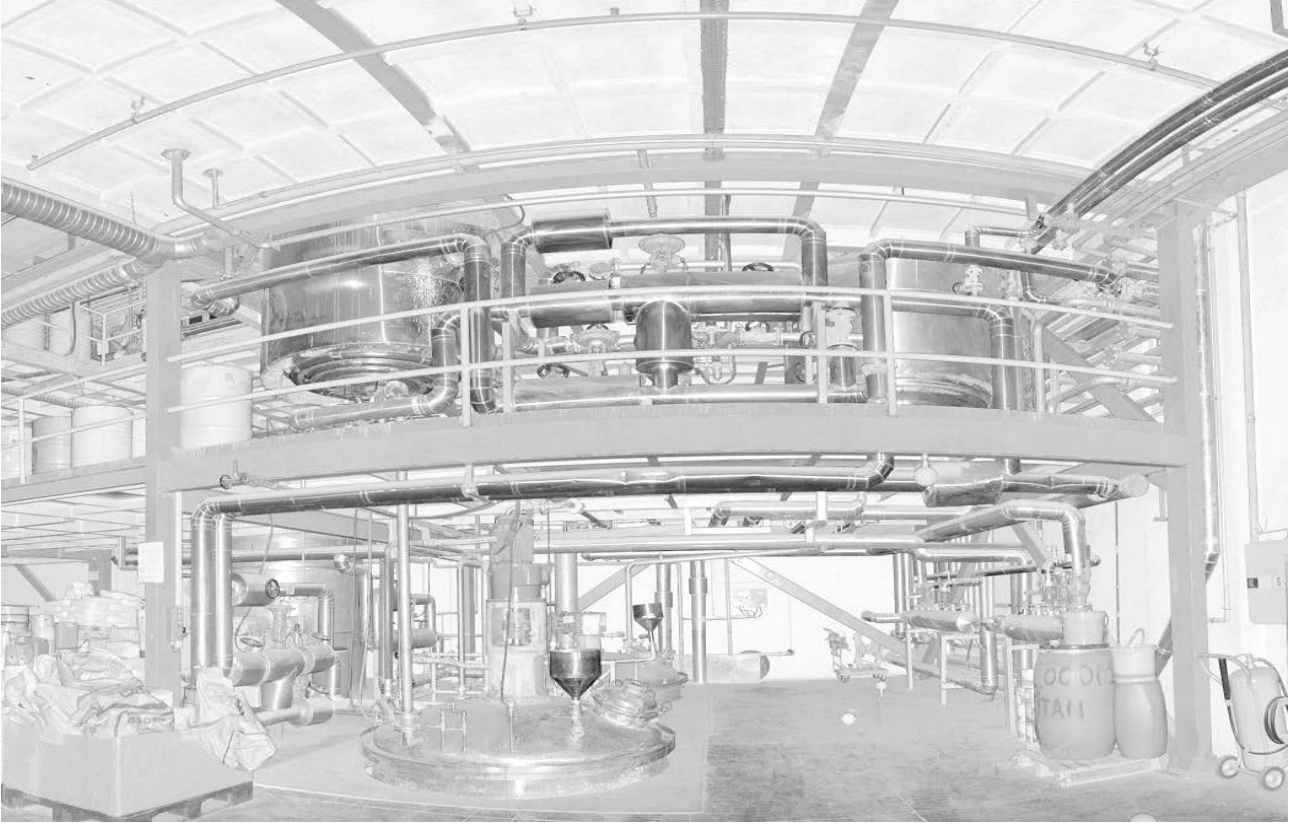
KİMYASAL ÜRETİM TESİSİ 3D LAZER TARAMA; BLENDER, EŞANJÖR VE REAKTÖR GRUBU
